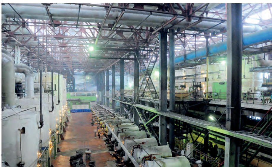
В цехах завода
