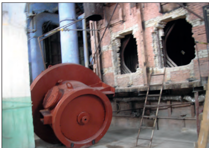
Рис. 3. Установка горелочных модулей муфельного типа для сжигания ВУТ и/или газа на ТЭЦ Владимир-Вольнского сахарного завода
