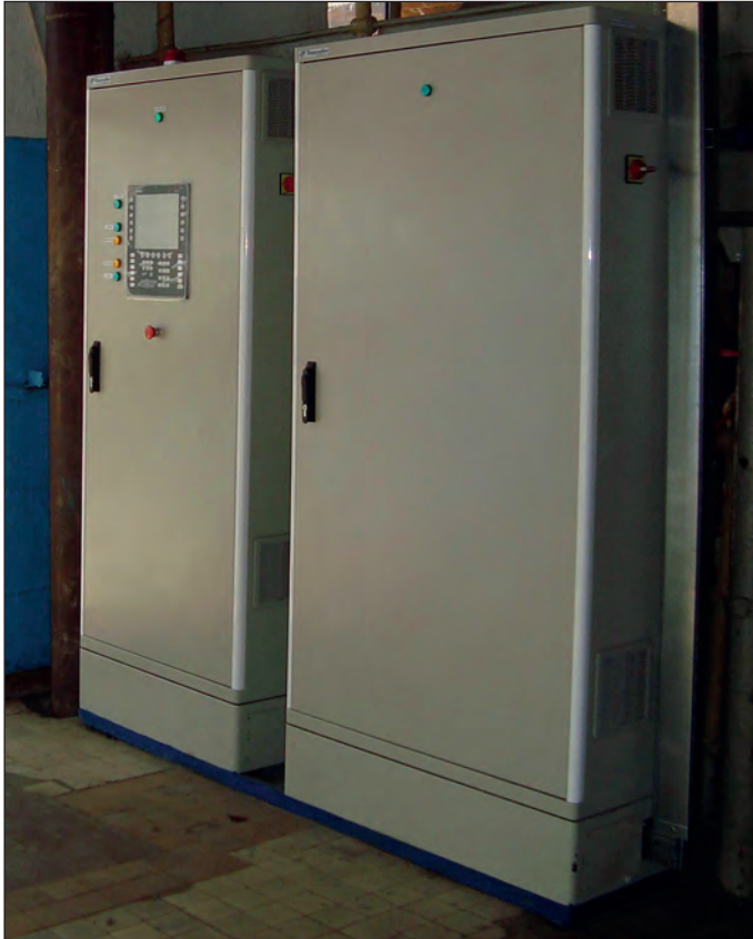
Рис. 2. Щит управления и щит преобразователей частоты САУ кристаллизации последнего продукта
