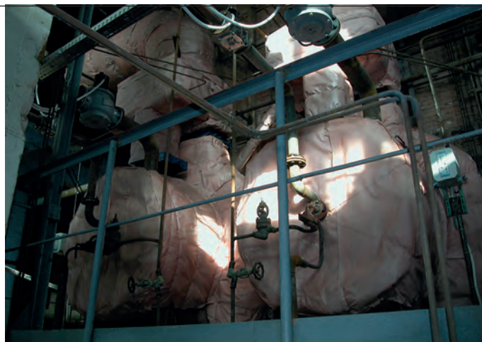
Рис. 3. Установка горелочных модулей муфельного типа для сжигания ВУТ и/или газа на ТЭЦ Владимир-Вольнского сахарного завода
