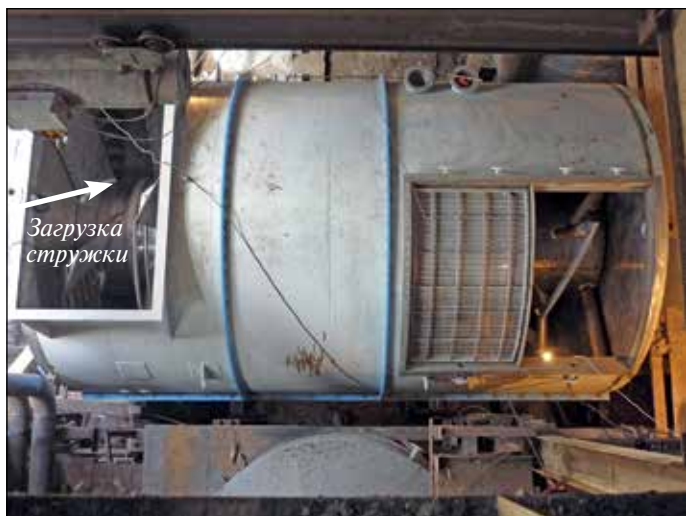
Рис. 3. Противоточный ошпариватель во время монтажа (вид сверху)
