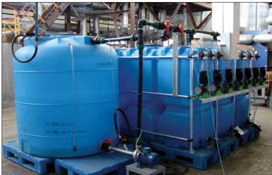
Рис. 1. Установка для подготовки и дозирования нового технологического корректора (НТК-2)
