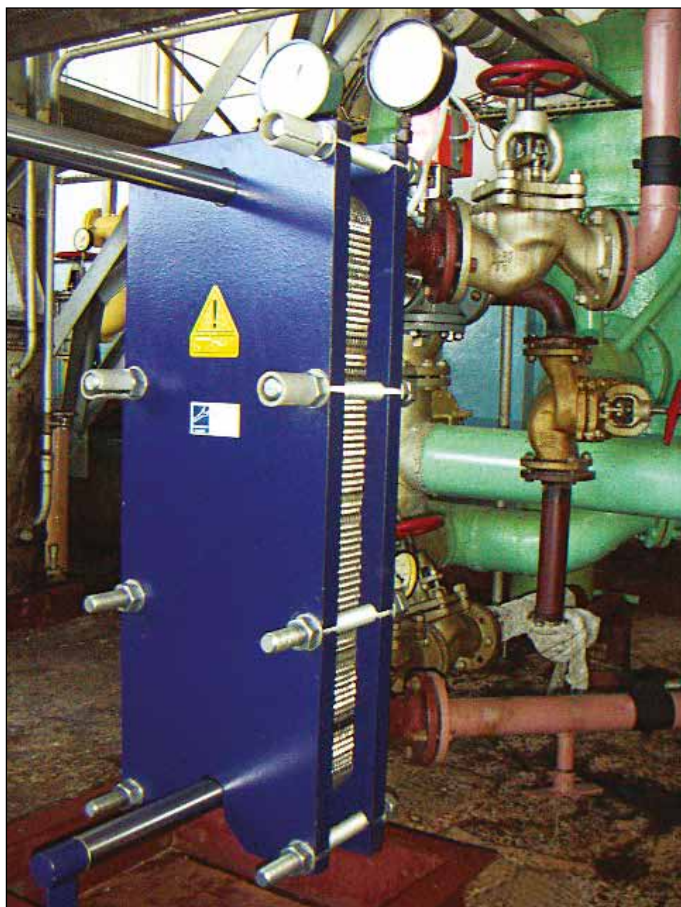
Рис. 2. Пластинчатый теплообменник «ГЕА Машинпэкс» на ОАО «Гиркубс» (Гулькевичский сахарный завод, Краснодарский край)
