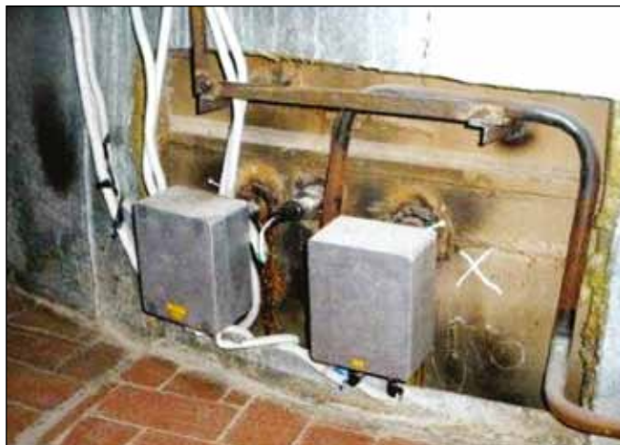
Рис. 1. Способ монтажа измерительного комплекса на аппаратах
