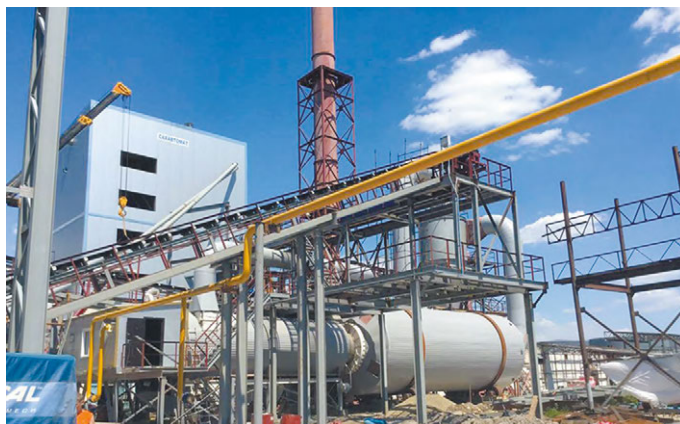
Рис. 11. Строительство нового жомосушильного отделения, монтаж оборудования и металлоконструкций, ПАО «Каневкссахар»
