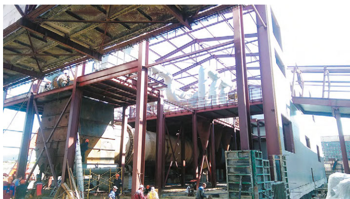
Рис. 5. Монтаж оборудования в жомосушильном отделении, ОАО «Знаменский сахарный завод»
