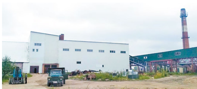
Рис. 10. Окончание работ, общий вид, ПП «Наркевичский сахарный завод»
