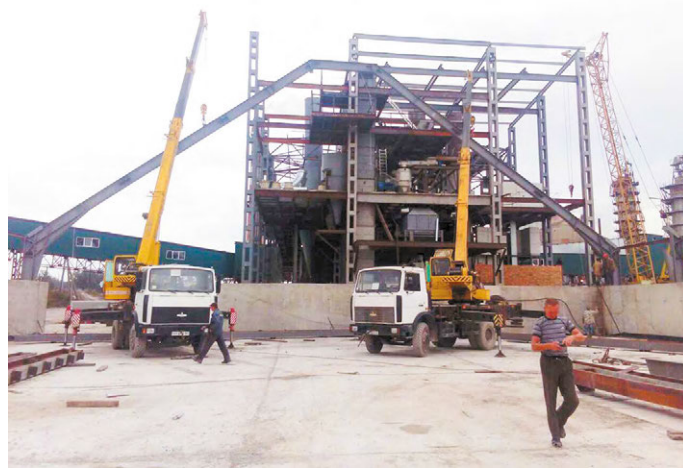
Рис. 8. Строительство склада хранения гранулированного жома на 8 тыс. т, ПП «Наркевичский сахарный завод»
