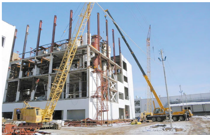
Рис. 2. Монтаж оборудования в главном корпусе завода, общий вид, ООО «Ангрен Шакар»
