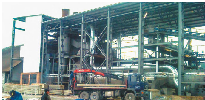
Рис. 9. Монтаж оборудования и металлоконструкций жомосушильного отделения, ПП «Наркевичский сахарный завод»
