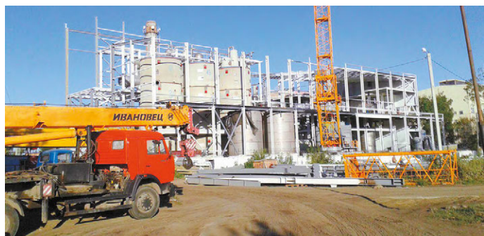
Рис. 6. Монтаж хроматографических колонн, ОАО «Знаменский сахарный завод»
