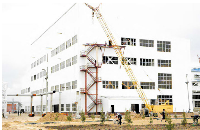
Рис. 4. Окончание работ, ООО «Ангрен Шакар»
