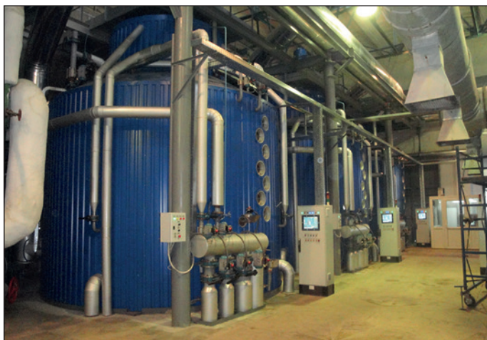
Рис. 3. Вакуум-аппарат с циркулятором марки ВАЦМ-70 для утфеля I ступени кристаллизации
