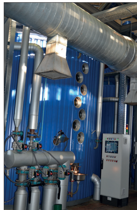
Рис. 8. Индивидуальный контроллер для вакуум-аппарата
