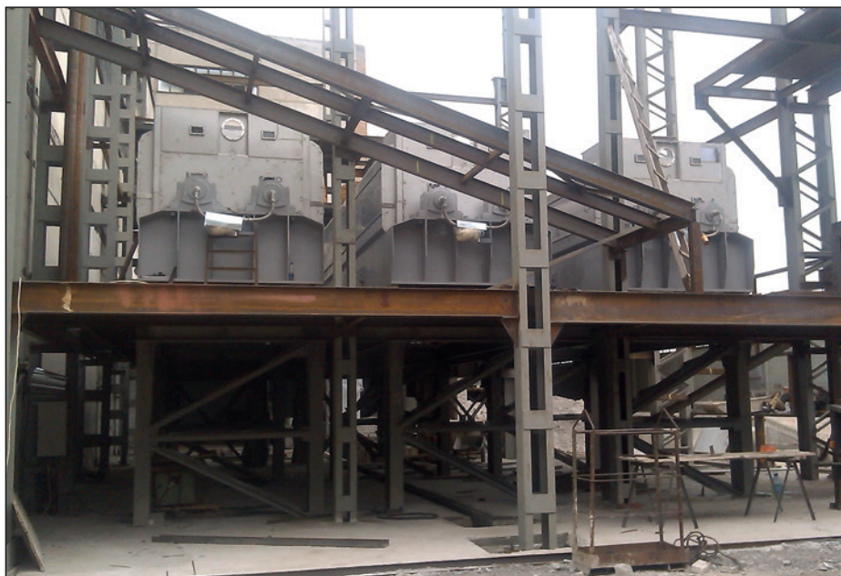
Рис. 1. Монтаж прессов глубокого отжима жомы системы Баббини марки PB 32 FS
