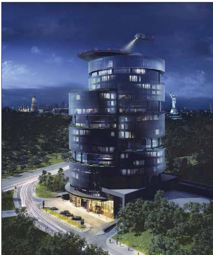
Рис. 14. Бизнес-центр IQ Business Center
