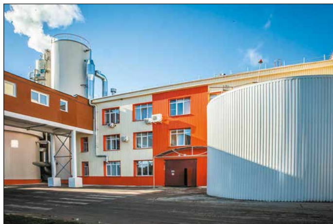
Главный производственный корпус
