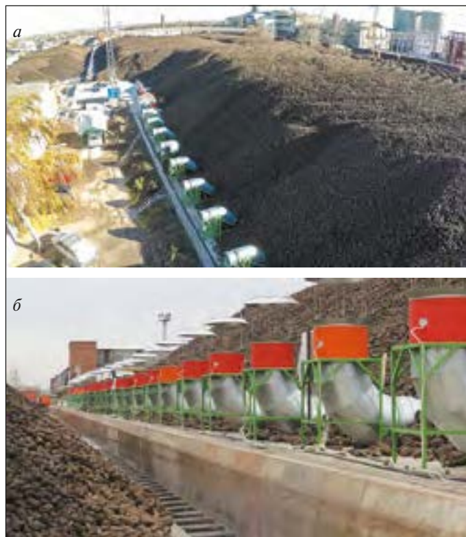
Рис. 2. Воздухораспределительная система горизонтального (а) и вертикального (б) исполнения Uceret
