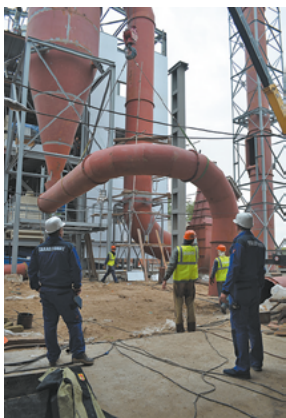
Строительные работы, монтаж технологического оборудования, металлоконструкций и трубопроводов
