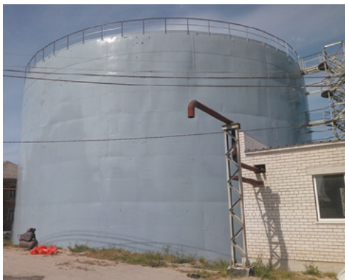
Поставка и монтаж стальных резервуаров ёмкостью от 3 000 до 10 000 м 3
