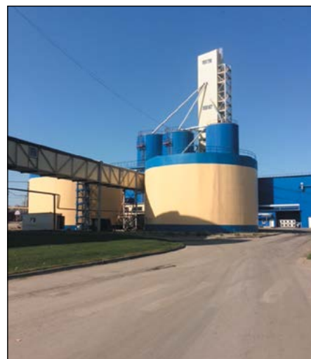
Новая установка для готовой продукции: дозреватели для сахара и паточный бак
