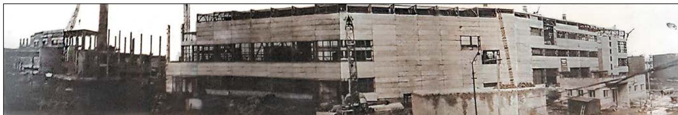
Строительство Каменского сахарного завода, конец 60-х годов XX в.
