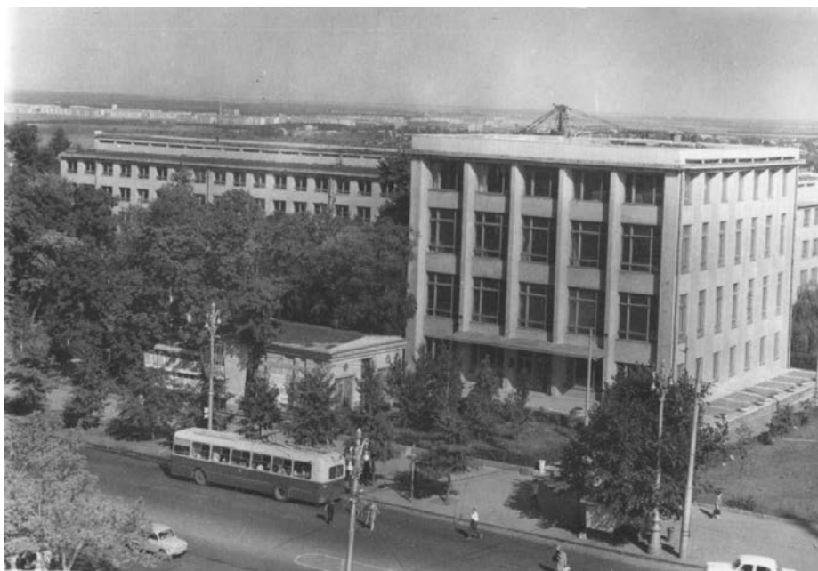
Фото 6. Учебно-лабораторный корпус Воронежского технологического института, построенный в 1960-х годах
