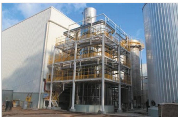
Инсталляция колонн хроматографии
