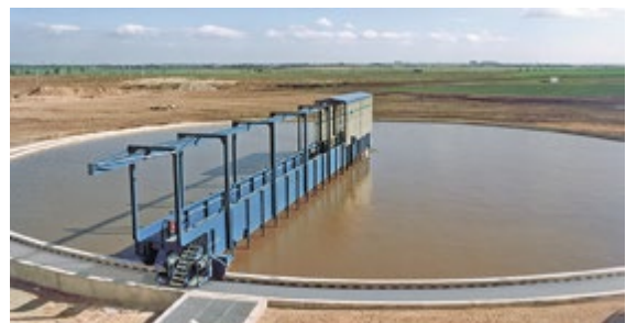
Putsch® - Радиальный отстойник для эффективного осадения
