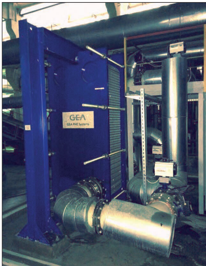
Разборные пластинчатые теплообменники ГЕА на Городейском сахарном комбинате
