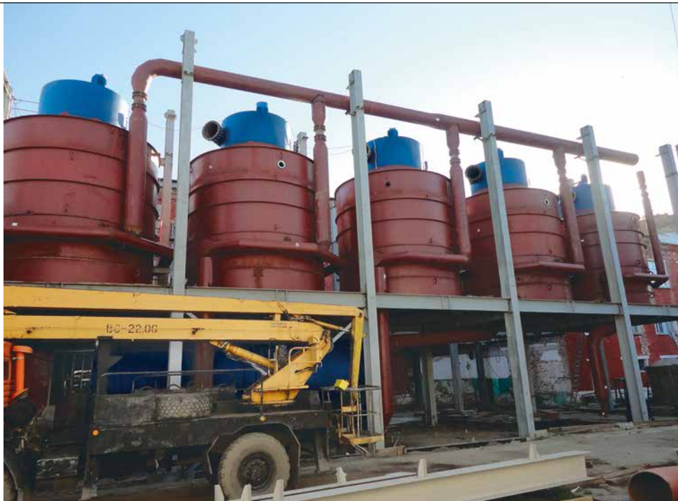
приемная мешалка утфеля (03.06.2013); в – смонтированные вакуум-аппараты (15.07.2013); г – вакуум-аппарат готов к работе
