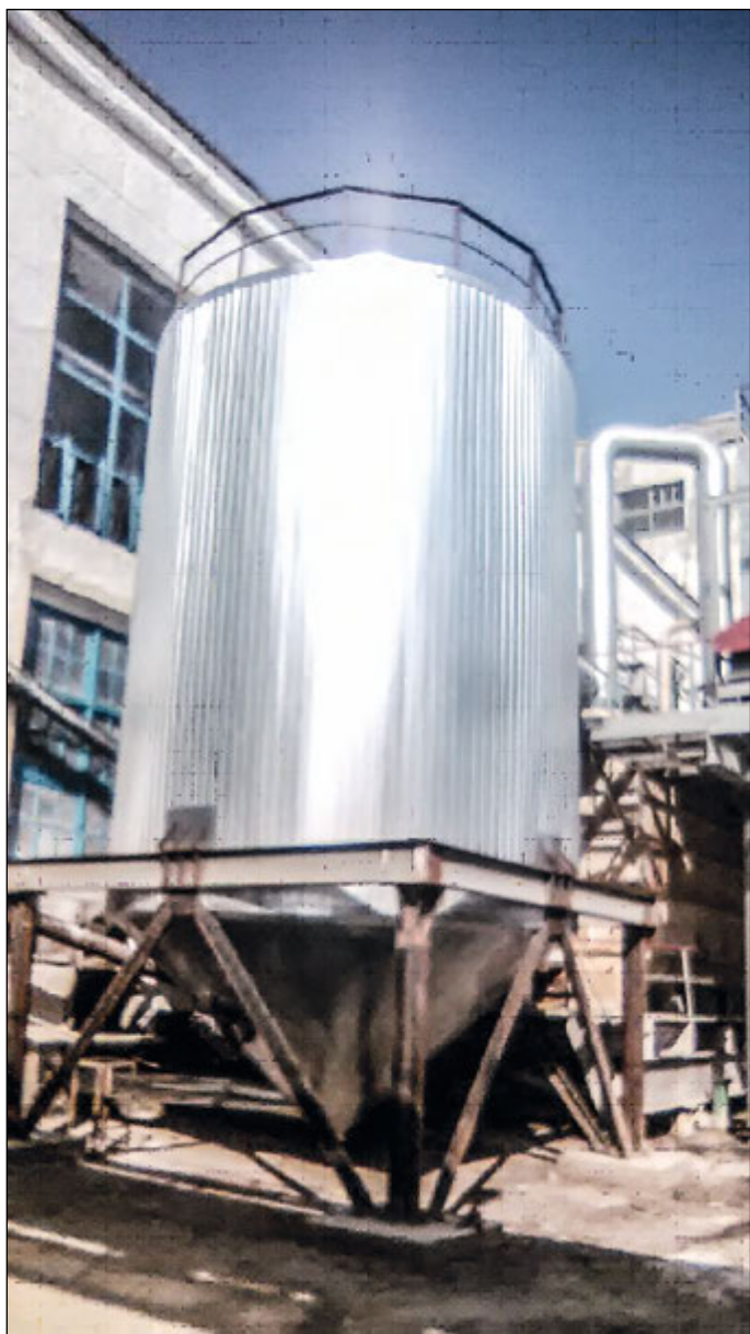
Рис. 2. Отстойник-дозреватель сока II сатурации производительностью 7 тыс. т свёклы в сутки
