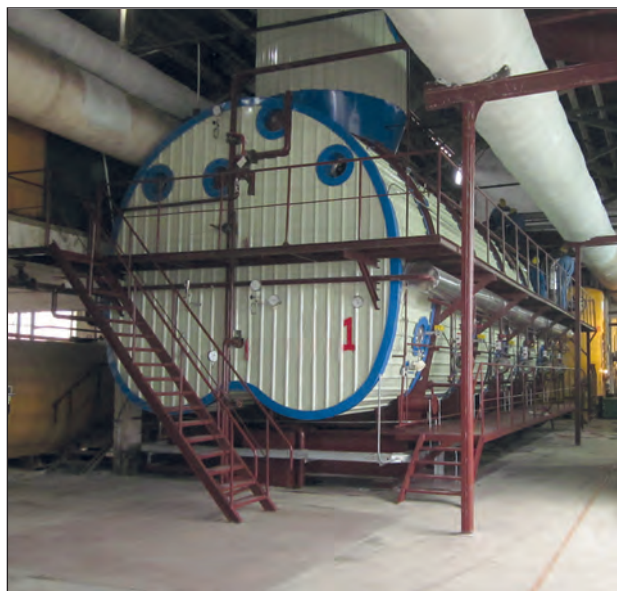
Рис. 7. Многосекционный ВАНД компании Fives Cail
